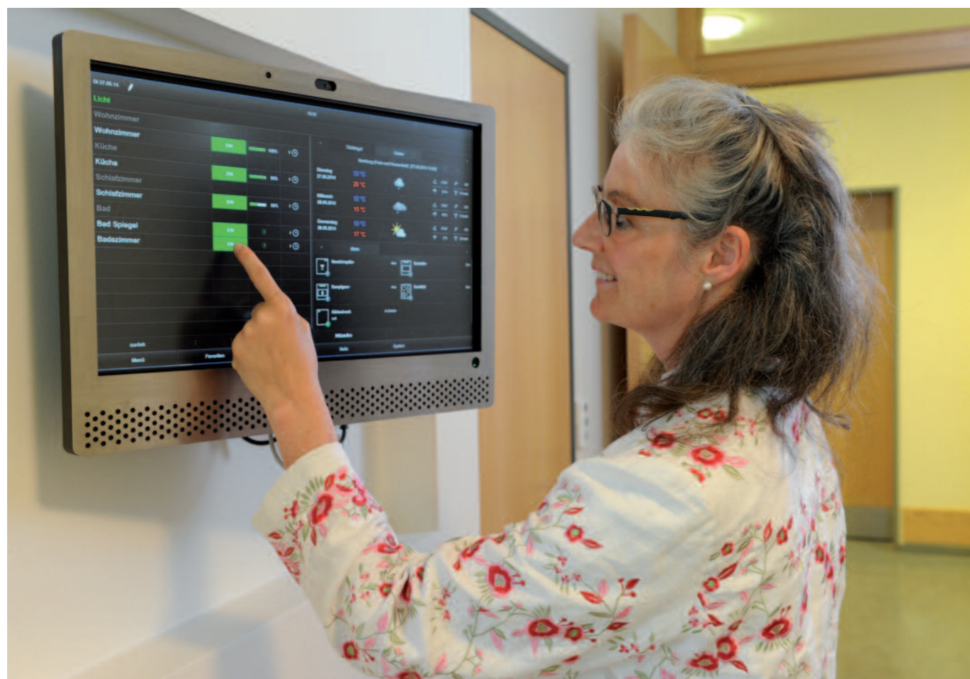
Die Steuerung der Smarthome-Technik kann zum Beispiel über einen zentralen Bildschirm mit Touch-Funktion erfolgen
