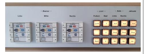
Die drei Bedienelemente links repräsentieren die drei installierten Beamer. Eine Indikatorleuchte zeigt den Zustand an.
